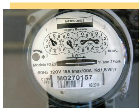
A quantidade de energia elétrica lida nos relógios de luz é medida em quilowatt-hora (kWh).
